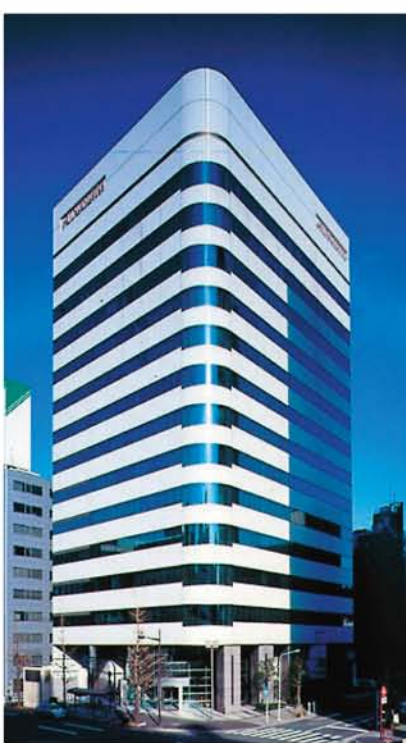
味の素(株)本社ビル
